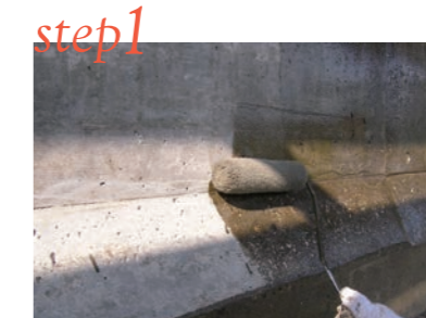
プライマー塗布
